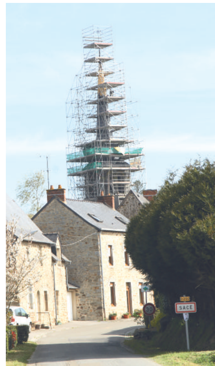
La rénovation du clocher en 2016
