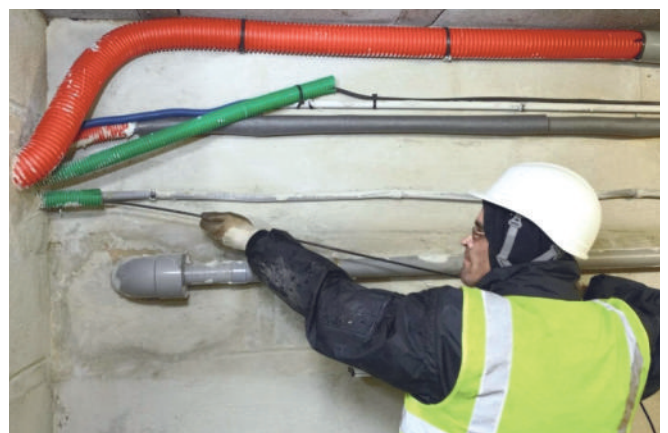
Tirage de la fibre dans le logement (©Mayenne Fibre)
