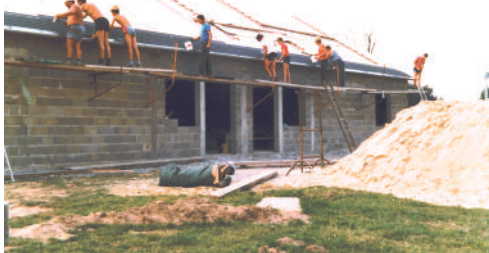
En juillet et août 1984, les habitants construisent la salle en totalité, des fondations jusqu'à être hors d'eau.
