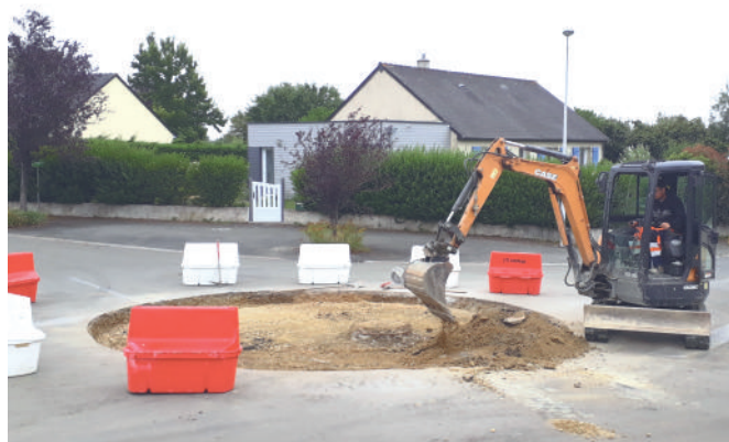
La construction du rond-point pour sécuriser les entrées des lotissements
